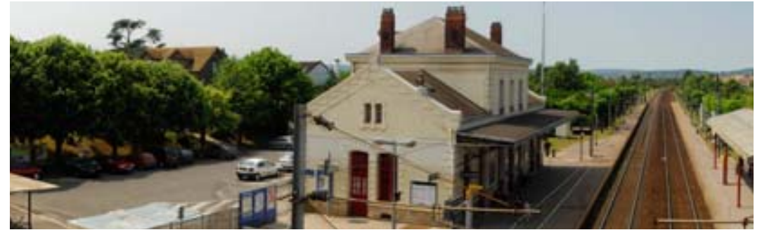
La voie SNCF , véritable coupure de la commune d'Andrésey
