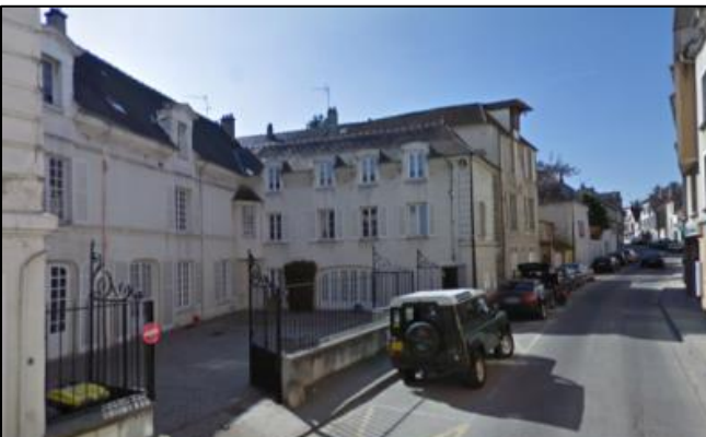
Ci-dessus, un mur de bahut offrant une continuité visuelle de la façade sur rue
