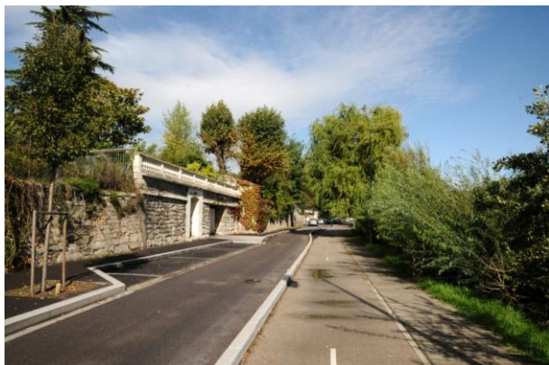
Murs de soutènement de propriétés en bord de Seine
