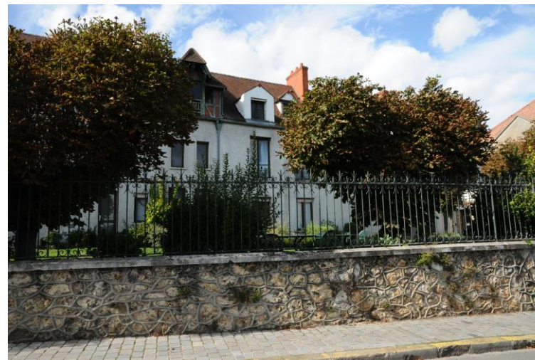
53 rue de l'Église, fiche patrimoniale n°41
