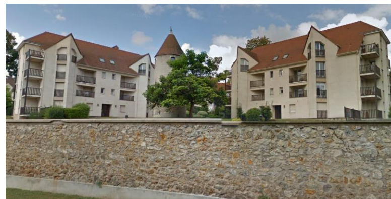
5 avenue d'Eylau (source : Google Streetview)
