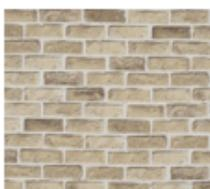
La brique est un élément de construction généralement de forme parallélépipédique rectangle constitué de terre argileuse crue, ou cuite au four, employée principalement dans la construction de murs.
