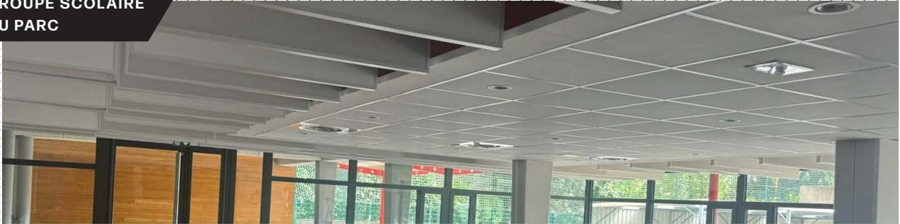
**Toit du restaurant scolaire :** isolation et pose de faux-plafonds coupe-feu, finition enduit, peinture et panneaux acoustiques, pose de structures porteuses et dépose de la toiture existante pour la remplacer suite à un affaissement et des infiltrations
