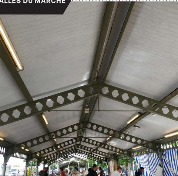
Nettoyage, blanchiment et réparation des sous-faces
