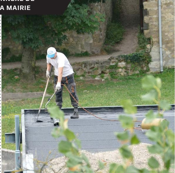
Rénovation complète de la toiture (étanchéité et nettoyage des gravillons) du service scolaire et du CCAS
